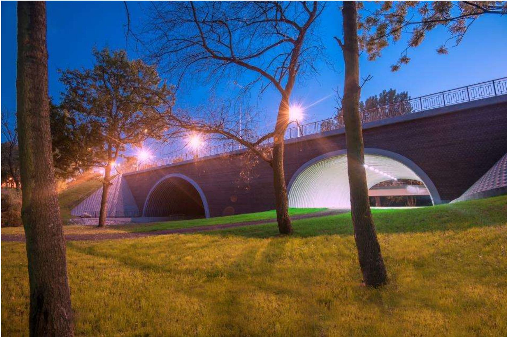
SuperCor® - Most na rzece Zgłowiączce we Włocławku - TAK JEST
