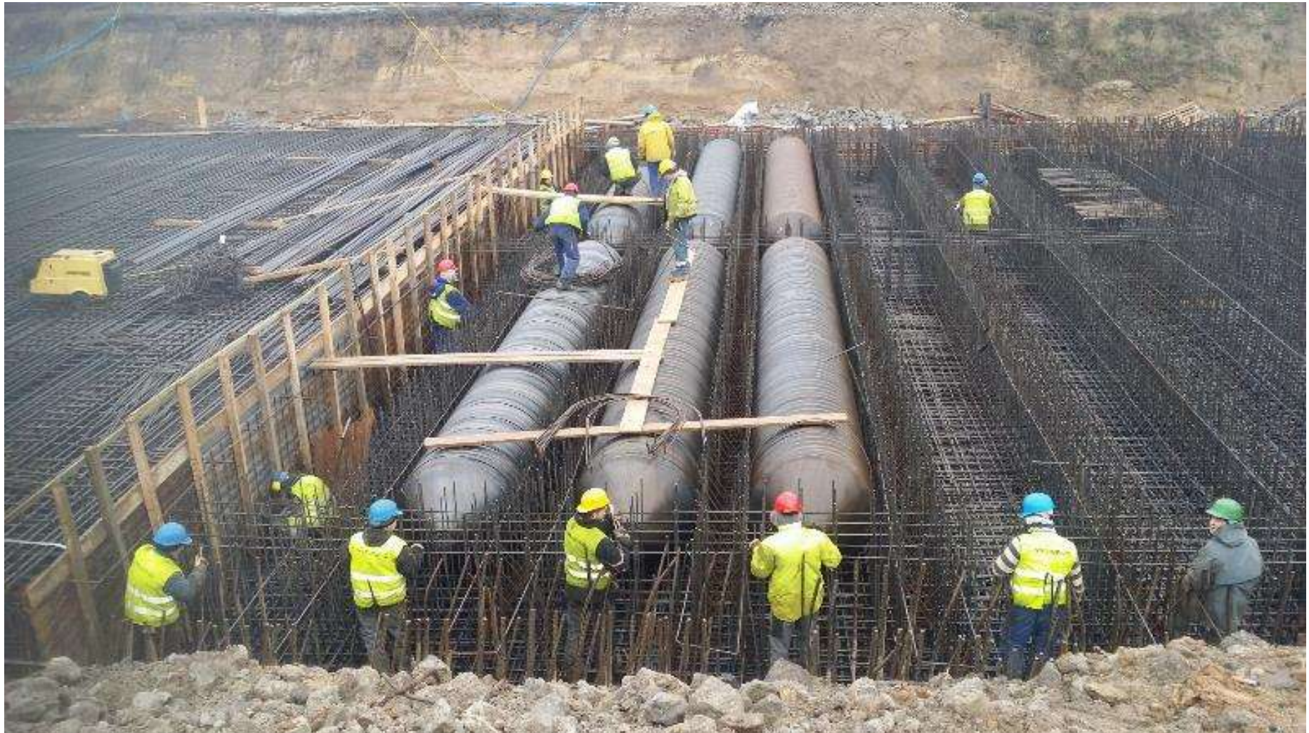
Budowa tunelu dojazdowego do budowanego Nowego Dworca kolejowego Łódź Fabryczna
