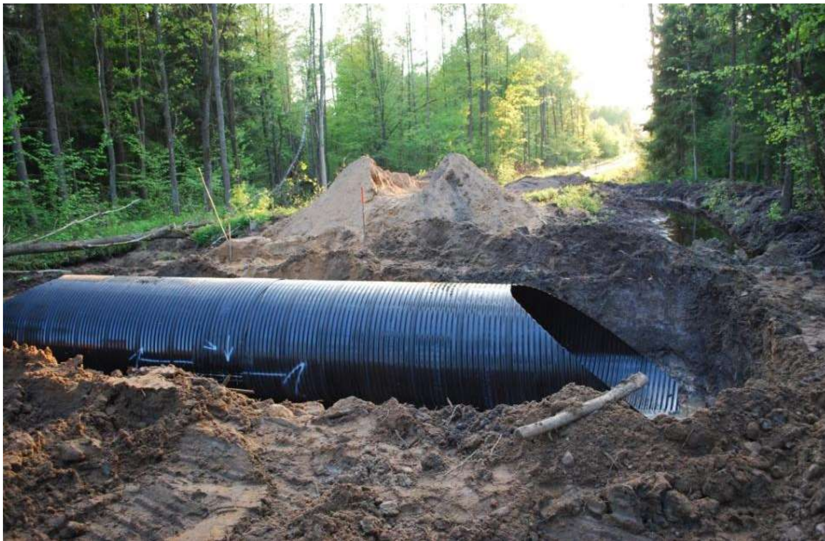
Budowa dojazdu pożarowego w Leśnictwie Wdowin i Siemiony
