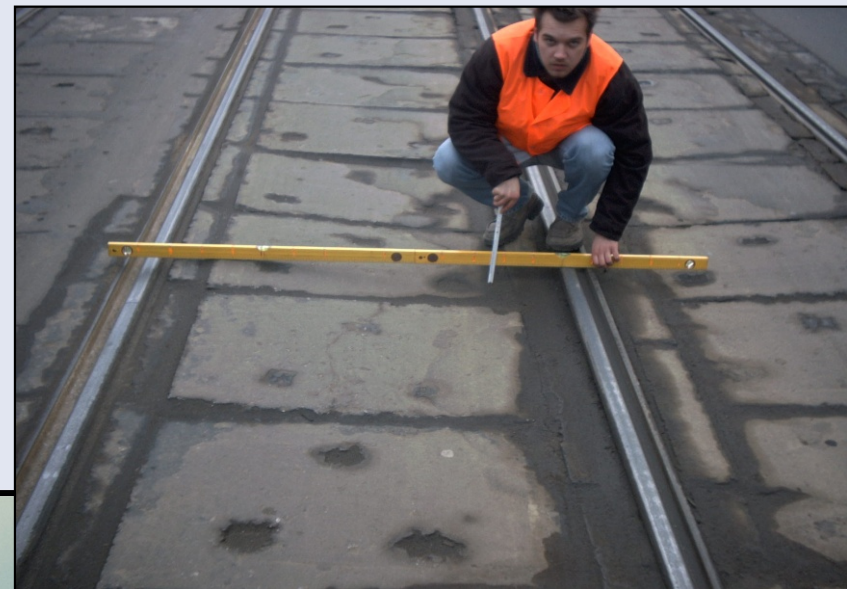
Zapadnięcie płyty i jej pęknięcia
