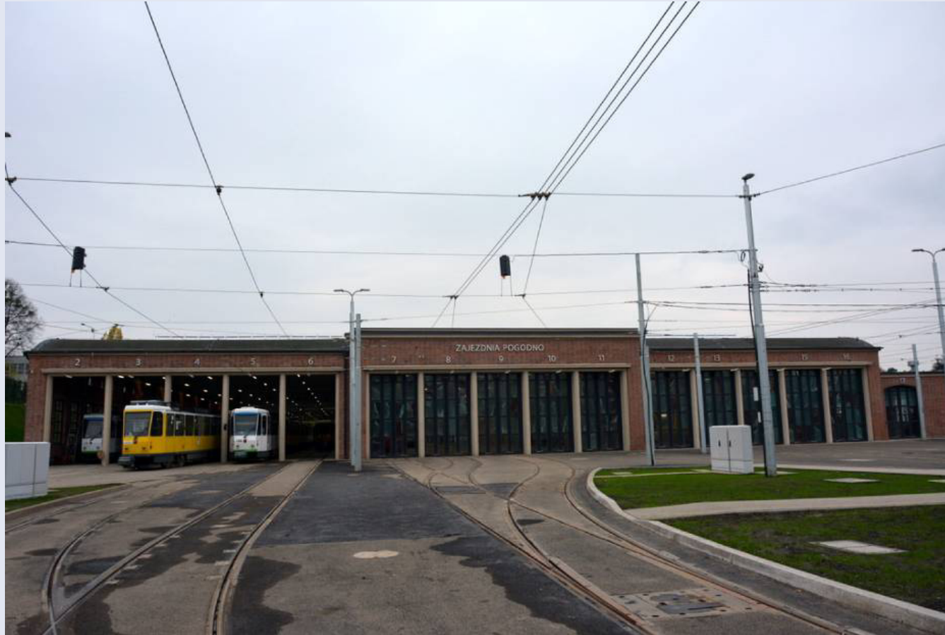
Przebudowana zajezdnia Pogodno – rok 2015
