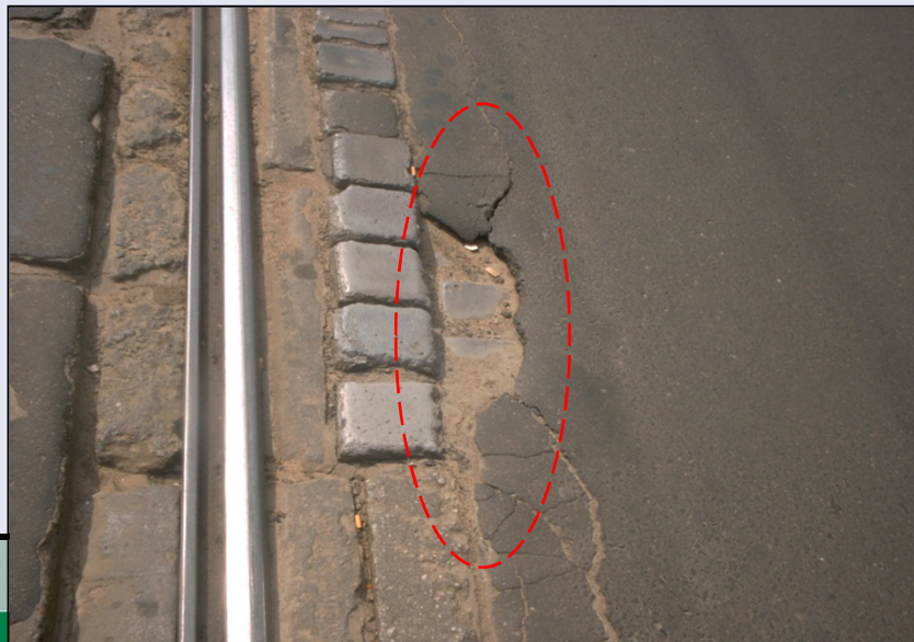
Ubytki nawierzchni
