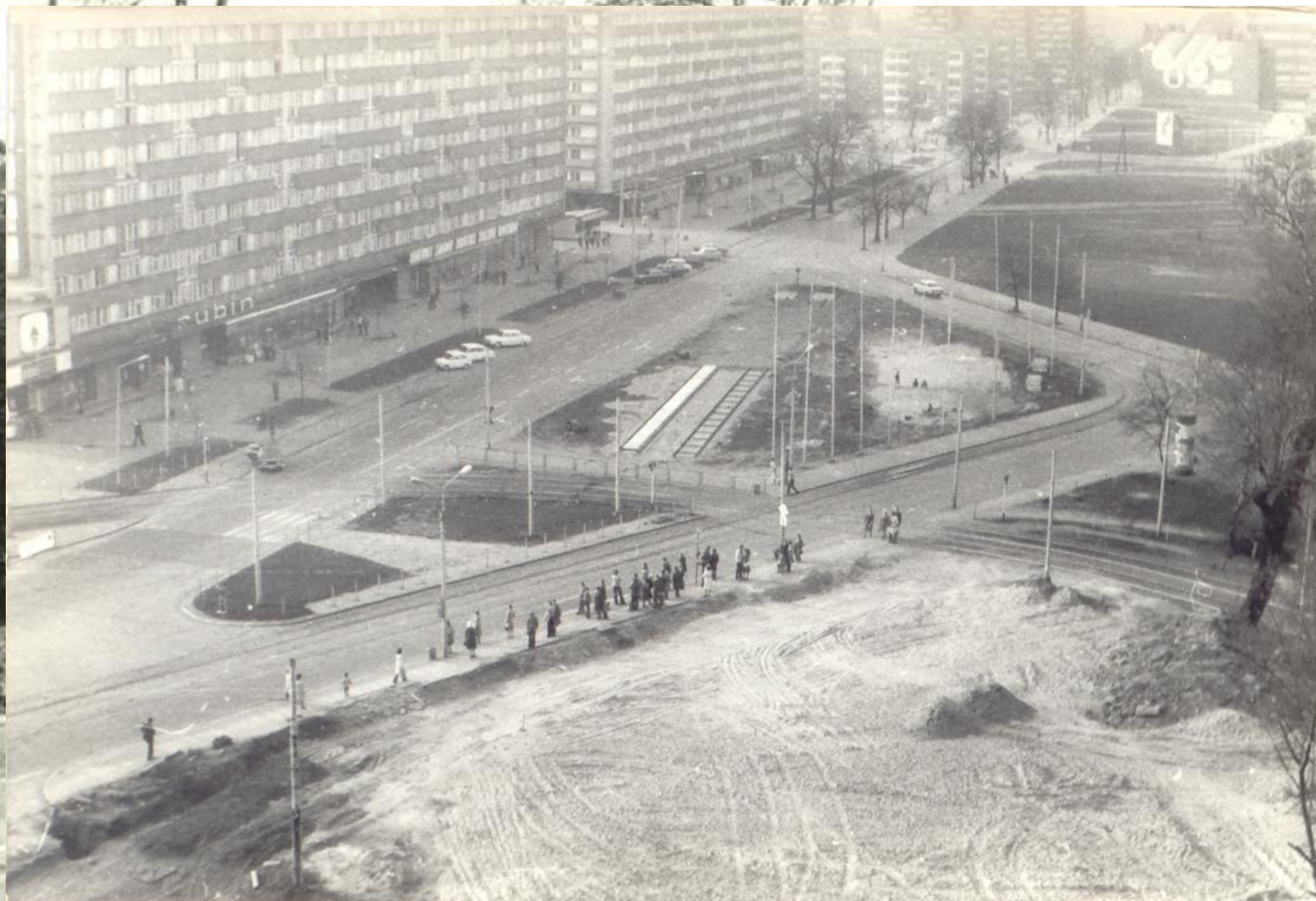
Budowa placu Rodła
