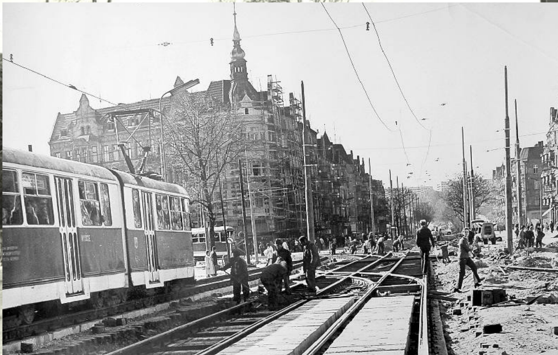
Przebudowa ul. Krzywoustego
