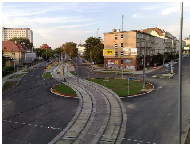
Przebudowane torowisko na rondzie Pileckiego
