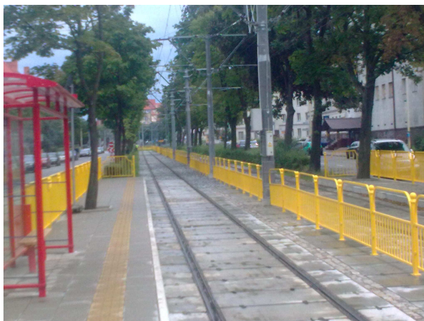
Podczas prac kierowano się głównie zasadą aby odtworzyć torowisko w planie w ramach procedury „zgłoszenia robót budowlanych”
