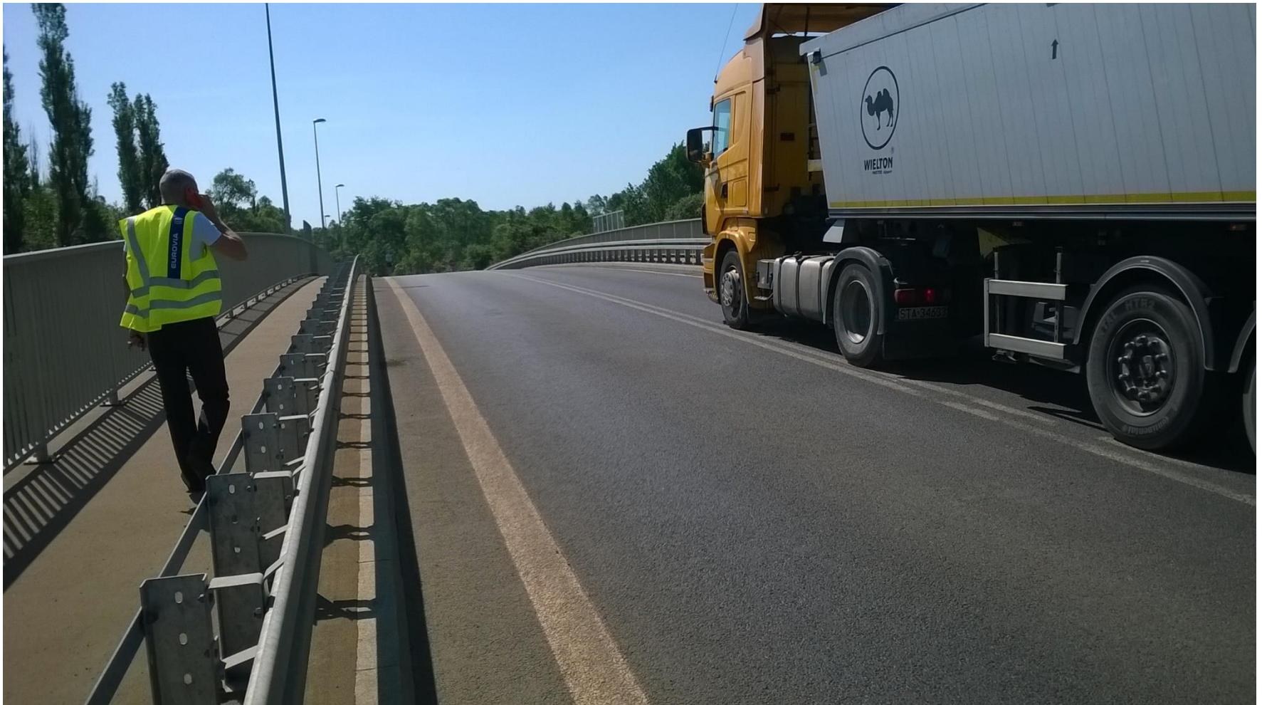
Rys. 19. Nawierzchnia na wiadukcie drogowym w Policach po 2 latach eksploatacji
