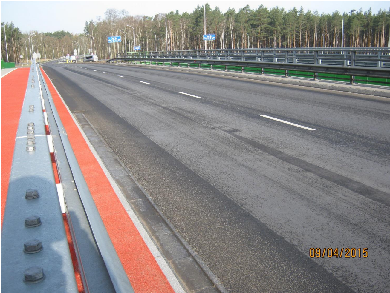
Rys. 17. Nawierzchnia na wiadukcie nad autostradą A6 (węzeł Tczewska) po 1 roku eksploatacji
