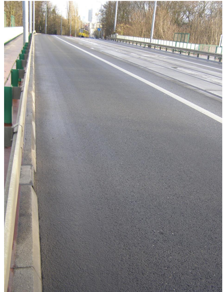
Rys. 12. Wygląd nawierzchni na wiadukcie w ciągu ul. Mickiewicza w Szczecinie po ok. 15 latach eksploatacji
