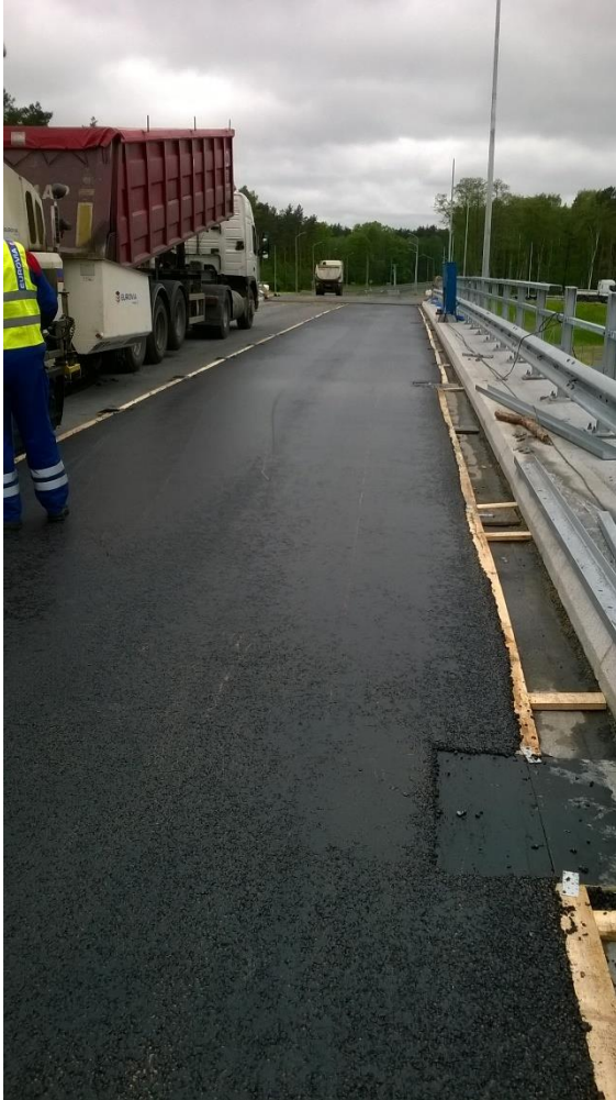
Rys. 16. Warstwa ochronna na wiadukcie nad autostradą A6 (węzeł Tczewska)
