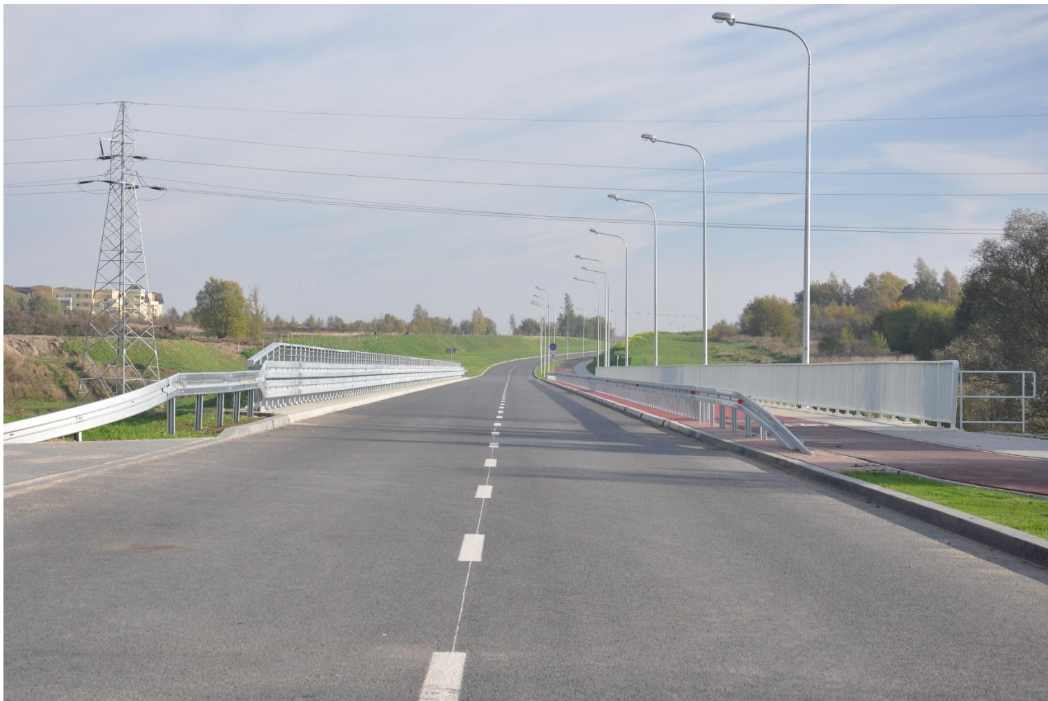
Rys. 20. Most nad rzeką Dzierżęcinka w Koszalinie po 1 roku eksploatacji
