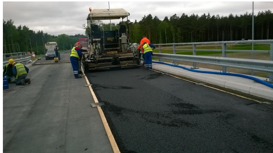
Rys. 16. Warstwa ochronna na wiadukcie nad autostradą A6 (węzeł Tczewska)
