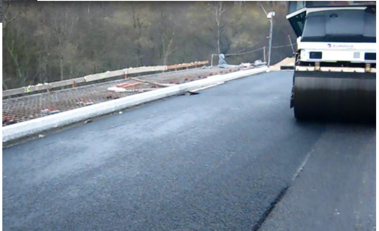
Rys. 18. Warstwa ochronna na wiadukcie drogowym w Policach - realizacja
