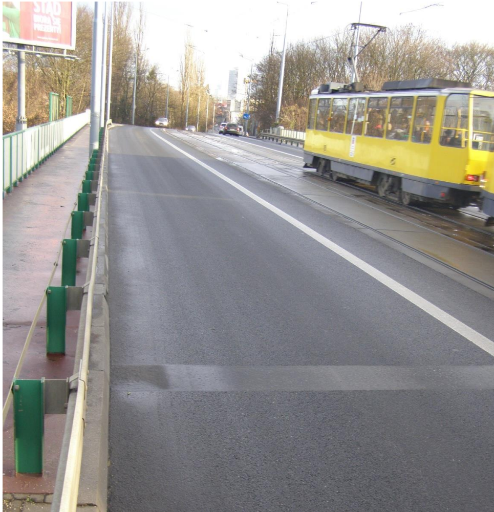
Rys. 12. Wygląd nawierzchni na wiadukcie w ciągu ul. Mickiewicza w Szczecinie po ok. 15 latach eksploatacji
