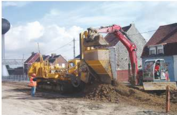
Instalacja drenów przy wykorzystaniu trenchera
